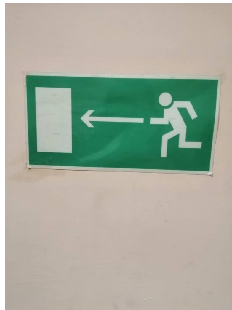
Фото №16 Визуальные средства путей эвакуации
